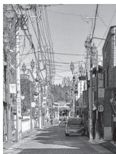
電線地中化される番場通り
